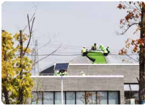
屋面绿化小组正在铺设草皮
