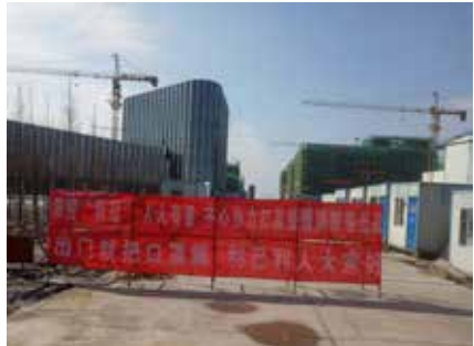
图为项目施工区域宣传条幅
