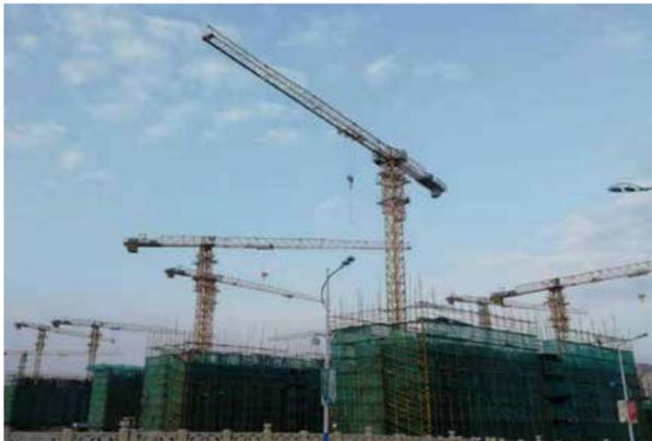
境保护方面，项目部每天派专人对噪音进行监测，防止噪音扰民；对裸露的土方，购买了大量的遮阳网对其覆盖并专门订制洒水车进行浇水，防止扬尘污染；塔吊夜间施工安装大灯定型罩，有效控制灯光方向和范围，在保证施工现场作业面有足够光照的条件下，减少对周围居民生活的干扰。通过项目部对细节的不断把控和努力，最终得到了相关部门的认可。
