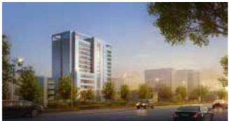
奉贤区奉城医院扩建外科综合楼项目，位于奉城医院内。本项目包含外科综合楼、地面开关站、污水处理站等三个单体建筑。外科大楼地上12层，地下2层，建筑高度49.1米（室外场地地坪至大屋面面层），规划高度54.65米（室外场地地坪至屋顶机房女儿墙）。新建大楼地面一至五层为医技等科室，六至十二层为住院病房。五层设空中连廊与5#楼病房楼相连接。地下共两层，主要功能为设备用房以及停车库，地下室总层高为9.3米。同步配套新建开关站及污水处理站各一栋，均为地下一层、地面一层。新建建筑总建筑面积19666.3平方米(其中：外科综合楼地上12层，地上建筑面积15055平方米、地下二层的建筑面积4432平方米；地面开关站140平方米和污水处理站39.3平方米)。
