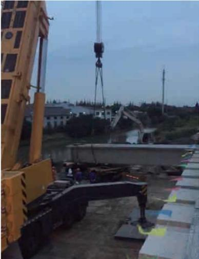
后缓缓将梁慢慢提升，提升的高度应超过墩的顶部。然后把杆进行旋转，板梁到位后缓缓放下就位。架梁人员登上桥台后，应配备安全绳，以防发生坠落事故。本桥跨径组合为12\*6+30+4\*16m。16米板梁每跨14片，主跨30米小箱梁为7片。根据施工现场情况，16米跨计划采用采用1台JQAY 300t汽吊架设，将每跨桥梁由南向北依次编号为1—14号；30米跨小箱梁计划采用采用1台JQAY 450t汽吊架设，将每跨桥梁由南向北依次编号为1—7号。先架设K4`K7跨，待K4`K7桥面做好铺装后，最后架设K3跨30米小箱梁。
