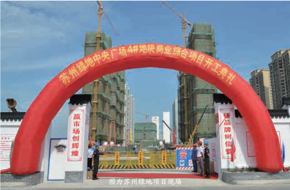
图为苏州绿地项目现场
