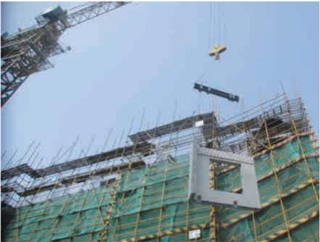
11#17F 楼栋采用装配式工法施工，装配式建筑面积为 16169.27 m²。装配式设计要求：预制率为 15%，外墙面积比为 50%。楼层外围一圈采用预制构件，主要预制构件有预制外墙、预制阳台、预制空调板、预制楼梯。
