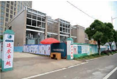
树浜110kv输变电站位于南桥镇百富路，该工程作业场地极其狭小，且采用新型结构，地下电缆砼结构及地上设备安装的钢砼结构。在施工期间由于进度要求高，众多分包班组紧锣密鼓的施工着，现场堆满了各种设备及各种材料，实在堆不下了，连项目部都难以幸免。如此形势下，土建在夹缝中求进度。
