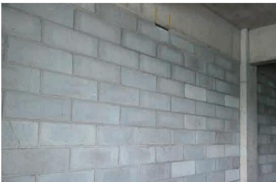
众所周知，成型完美的砖块可以给人最直接的观感美，也从源头上解决了成品的缺陷问题，因此在砌筑砖块到现场时项目部管理人员会对每一块原材进行汇总，严格按照良好、合格、一般、废品四个等级进行处理，当然了对于成型较好的原材总是砌筑在醒目位置，而“废品”也响应集团公司节约材料的指示做到物尽其用，主要用于切割加工成半成品，用在一些不重要的临边维护及零星位置。在事中控制中项目部积极组织技术力量，在砌筑开始后对于大面墙、转角墙、有施工预留洞的墙体进行砖块排列组合并以图文的形式展示，这只是让砌筑的墙体不要产生原则性错误，在工人砌筑时及时进行观感目测，查看是否按照事前质量控制的技术文件资料组织实施，并带上质量检测仪器及时进行检测，发现质量问题迅速查找原因，使砌筑的质量始终处于受控状态，但我们也清醒认识到无论做的多好也无法避免事后质量补救的存在。对于事后质量控制我们项目部把重点放在成品保护上，除了对砌体的外观质量进行修补外，我们还对产生的质量问题追溯并做简单的纪要为后续的砌筑工程积累宝贵的数据资源。而对于一些质量“通病”可能衍生的次生质量问题做到及时有效的预防。
